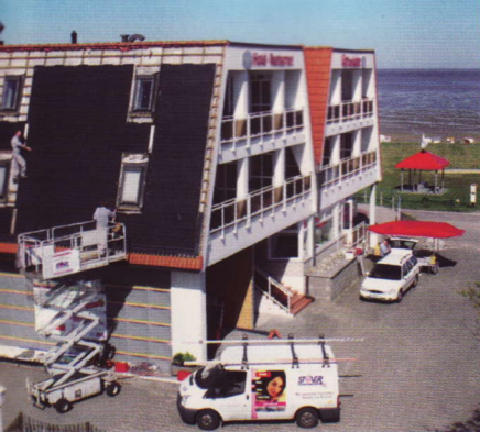
Montage der Solarthermie-Module auf dem Dach des Hotel „Wattenkieker“.
