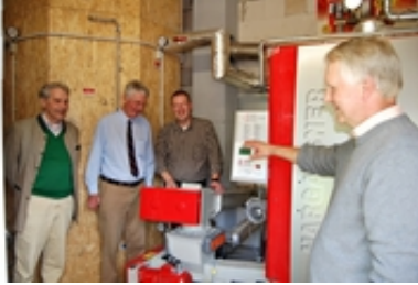
High-Tech hinter alten Mauern : Jürgen Meyer (rechts) erklärt Christian von der Wense, Dr. von Reden-Lütcken und Ingo Stöver (von links) die neue Heizungsanlage im Kloster Neuenwalde. Foto ire
